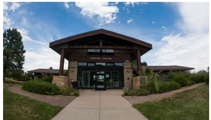
Existing Visitor Center
